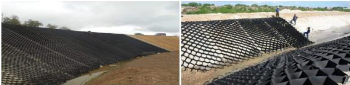
2 pav. Šlaito stiprinimas Geokoriu
