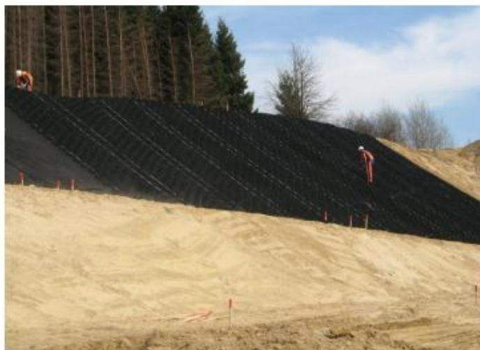
3 pav. Šlaitas sustiprintas geotekstilės paklotu
