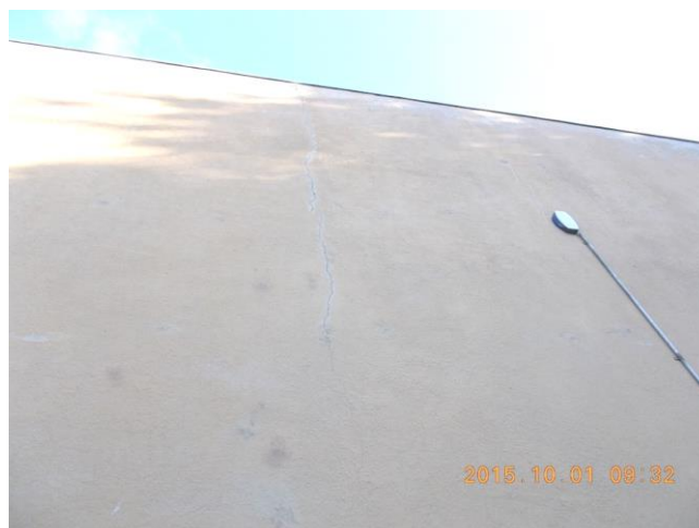
5 pav. Plyšys, atšokantis tinkas
