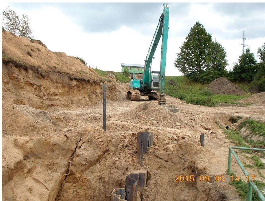
2 pav. Atvirųjų pjezometrų įrengimas užtvankos žemutiniame šlaite Šaltinis: sudaryta autorių
