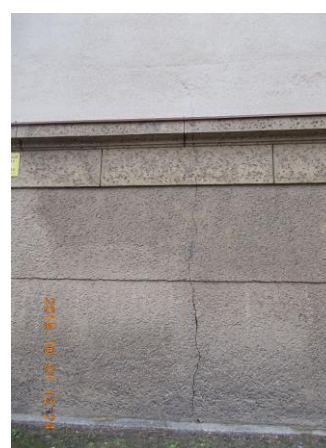
6 pav. Įstrižieji ir vertikalieji plyšiai, tinko irimas
