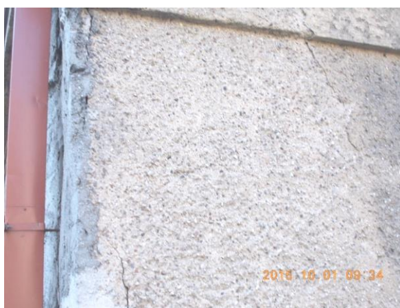
6 pav. Įstrižieji ir vertikalieji plyšiai, tinko irimas
