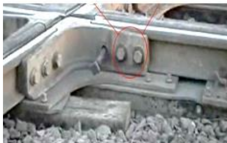
2 pav. Jungimo varžtas-veržlė naudojimo geležinkelio bėgiams jungti nuotrauka
