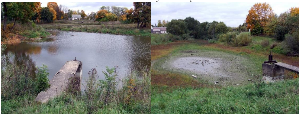
4 pav. Šachtinio tipo perteklinio vandens pralaidos Gylių III ir Gylių IV apleistuose hidromazguose
