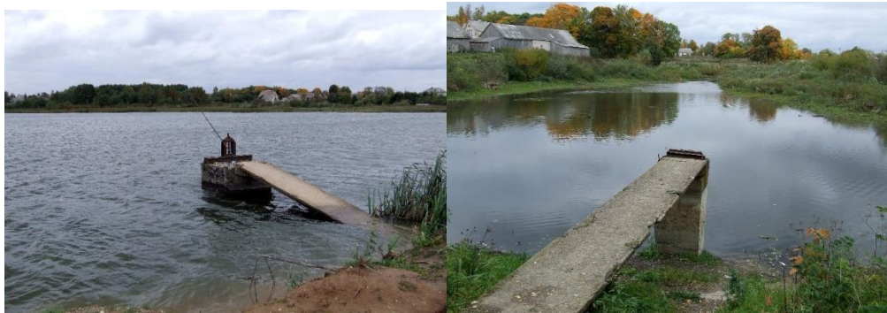
3 pav. Šachtinio tipo perteklinio vandens pralaidos Gylių I ir Gylių II apleistuose hidromazguose
