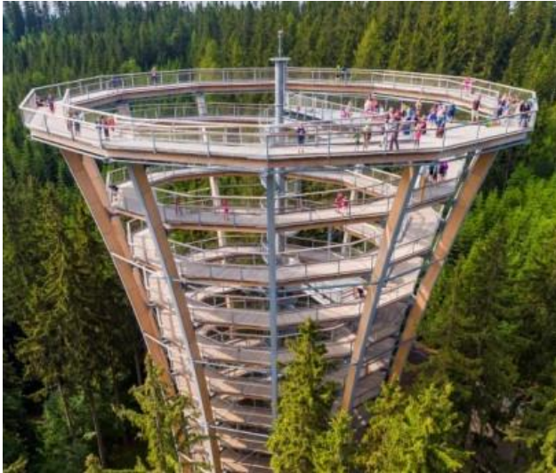
Bendras ilgis: 1500 metrų Bokšto aukštis: 45 metrai 80 metrų ilgio tunelinė čiuożykla
