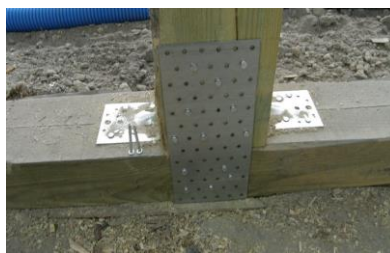
2 pav. Medinių elementų tvirtinimo detalės [14]
