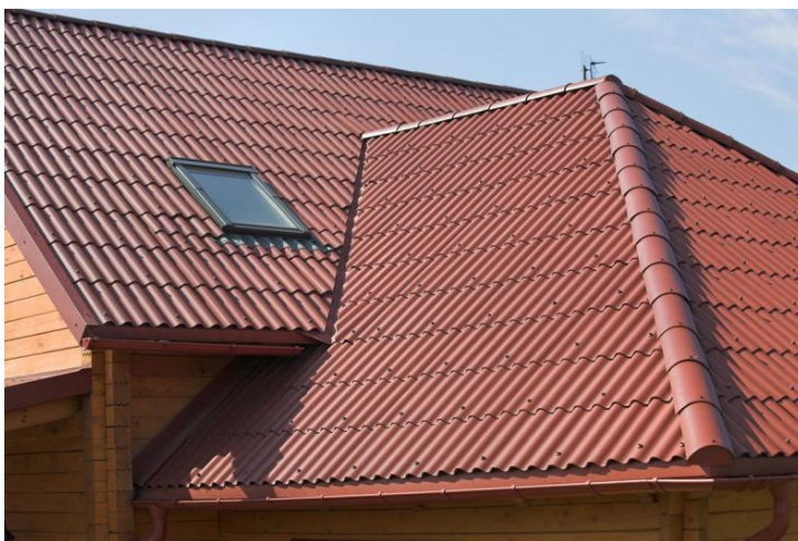
4 pav. Beasbestinio šiferio lakštų stogo danga [1]
