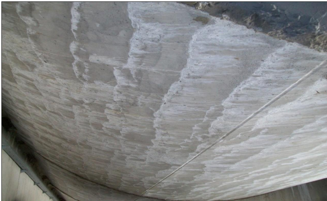
4 pav. 3 vamzdžio 17 sekcijoje vamzdžio apatinės dalies paviršius suaižėjęs, sunkiasi vanduo, išplaudamas kalcio hidroksidą
