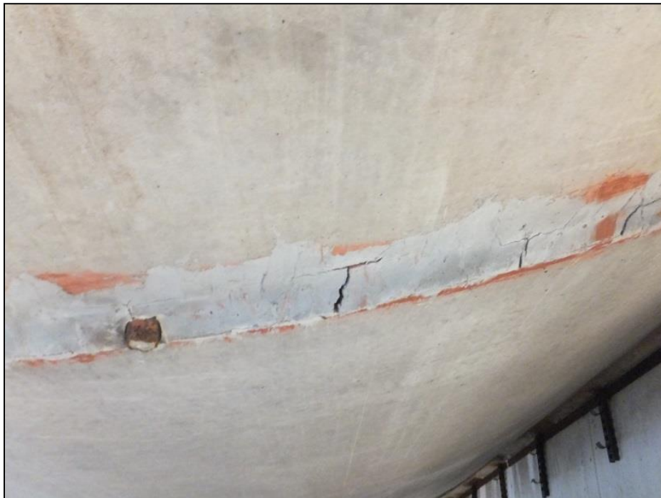
6 pav. Vamzdyno sekcijas jungiančios siūlės užtaisytos cementiniais skiediniais, kurie supleišėję Šaltinis: sudaryta autorių
