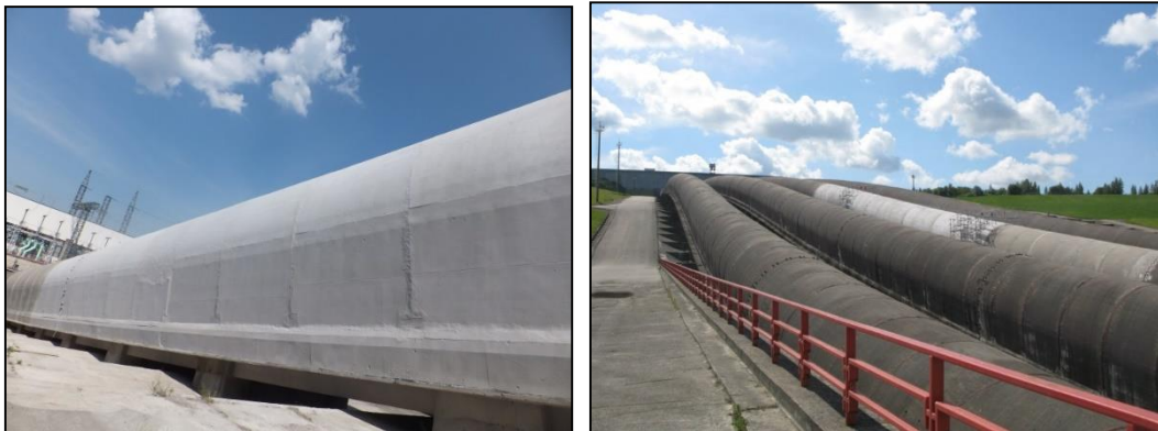
10 pav. tęsinys 3-iojo vamzdyno dalies remontas ir paviršiaus dažymas Šaltinis: Lietuvos energija (foto R.Vileikio)
