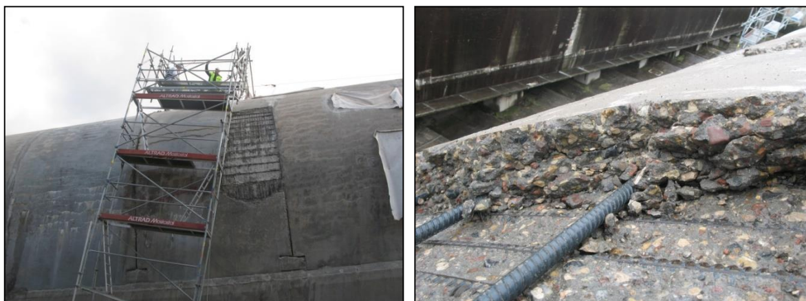
10 pav. 3-iojo vamzdyno dalies remontas ir paviršiaus dažymas Šaltinis: Lietuvos energija (foto R.Vileikio)
