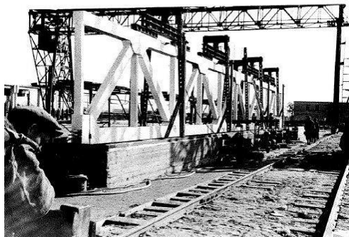
3 pav. Gelžbetoninė santvara
