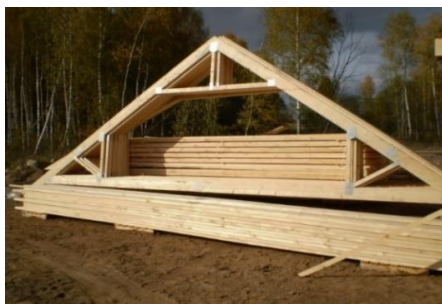
2 pav. Medinė santvara
