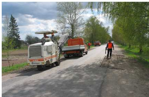
8 pav. Vieno iš asfalto dangos defekto – kraštų išstrupėjimo – remonto epizodas
