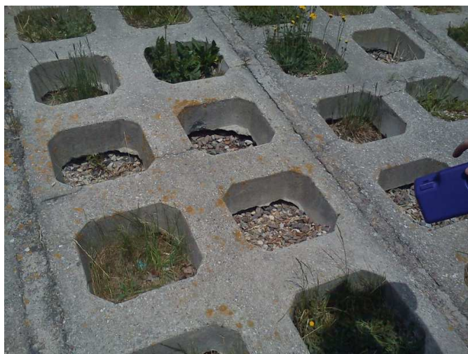
8 pav. Paplautas pagrindas iš po plokščių Šaltinis: fotografuota autorių
