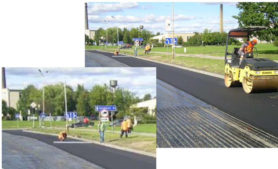
4 pav. A/b sluoksnio lygumo kontrolė sutankinus naują sluoksnį
