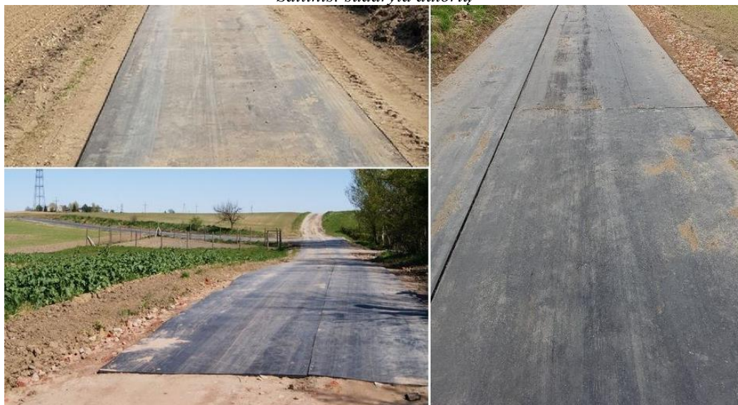
4 pav. Laikino kelio įrengimas panaudojant guminę dangą
