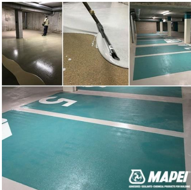
3 pav. Poliuretancemento danga „Mapecfloor CPU/MF“ [1]
